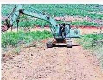
హరిపురంలో పాకెయిన్తో రహదారి పనులు
